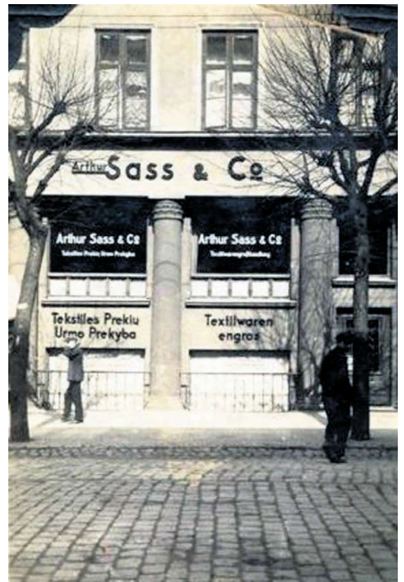
■ Наследие: на улице Тургаус сохранилось здание магазина бакалейщика А.Сасса.
